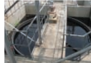
排水処理設備による浄化処理
